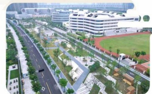
● 萧政储出（2019）26号地块配套道路及桥梁工程
