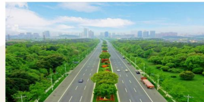
● 迎春南路(320国道-杭千高速入口)景观工程
