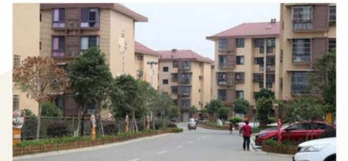
● 星联村安置小区配套工程
