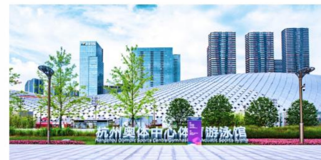
● 钱江世纪城亚运重点展示区及核心场馆区景观绿化工程
