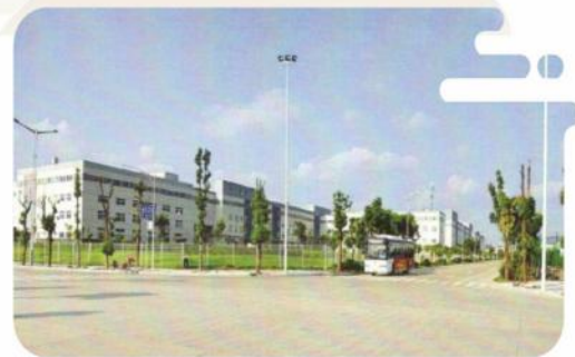
● 江东工业园区江东一路拓宽路灯工程
