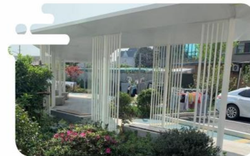
● 蜀山街道湖东村城郊结合部现代社区（未来乡村）公共服务设施及配套提升工程
