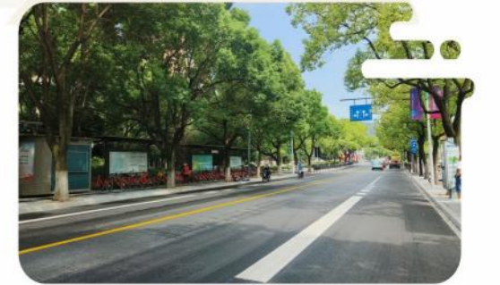
● 2023年亚运通勤道路提升工程人行道整治
