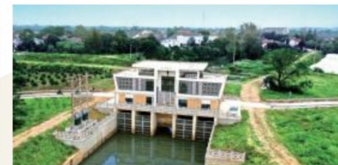
● 长兴泗安塘流域综合治理项目
