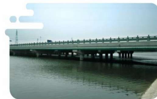
● 温州高教园区北入口桥梁工程
