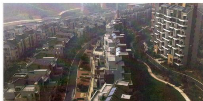
● 创新基地海曙路工程(经一路-良睦路)
