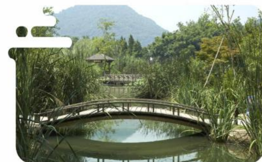
● 杭州市西湖长桥溪截淤整治工程园林绿化、土建施工
