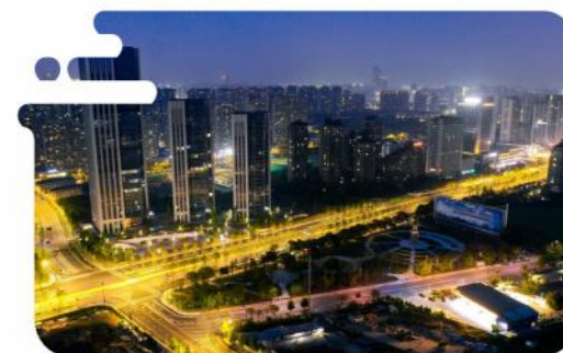
● 金城路改造提升工程
