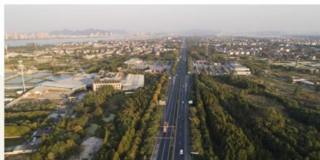
杭州绕城高速公路路面大中修工程
