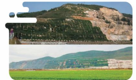
● 南太湖新区杨家埠街道戚家山矿区边坡滑坡地质灾害隐患治理工程
