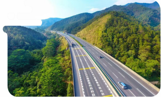
● 广州至河源高速公路惠州段工程
