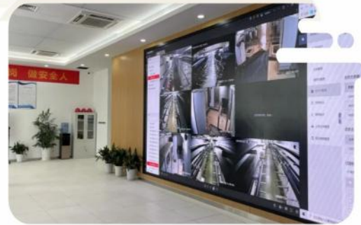
● 钱江世纪城综合管廊项目
