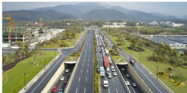
紫之隧道路面工程
