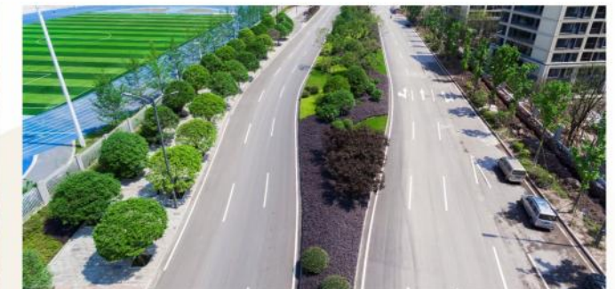
渝江路二期景观工程、御临河西侧截污干管沿线道路
