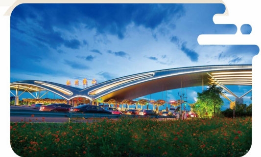
● 杭州萧山机场公路两侧景观整治——夜景照明工程三标段
