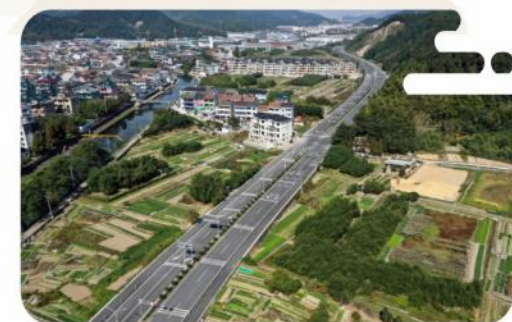
● 柯桥西南通道工程
