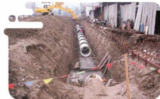
● 03省道东复线北伸污水管工程
