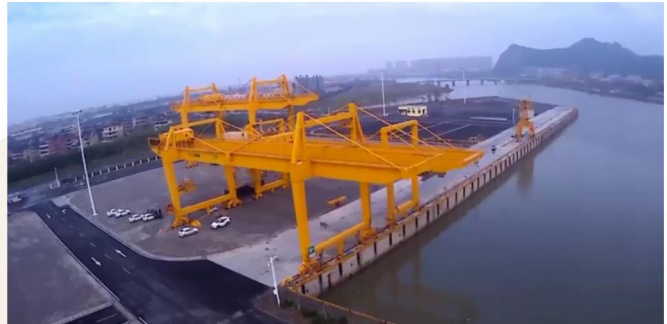
● 杭州港萧山港区义桥作业区工程
