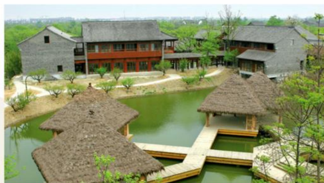
● 杭州市西溪湿地综合保护工程一期工程历史建筑复建和修缮工程
