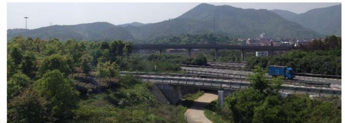
● 杭州乔司至南苑连接线下穿沪杭客专一号通道工程施工
