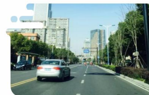
● 城市道路平整和环境景观提升项目-金鸡路等3条道路（标段二）
