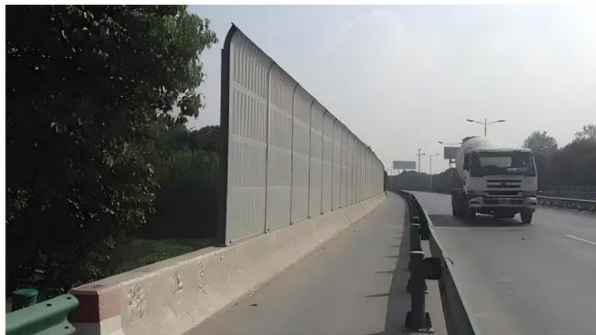
● 104国道声屏障安装工程
