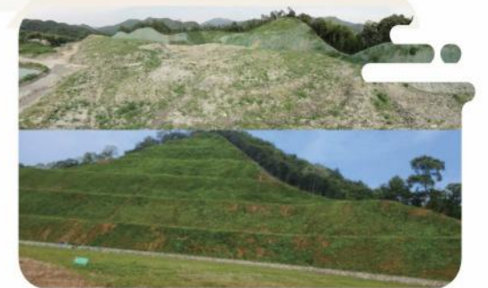
● 杭州市萧山区临浦镇王村石料场废弃(关停)矿山生态环境治理工程
