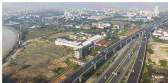
● 仓前工业园区环境提升工程海曙路(东西大道-绿汀路)项目
