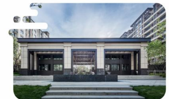
中国金茂青岛高新区项目A5地块园林景观工程
