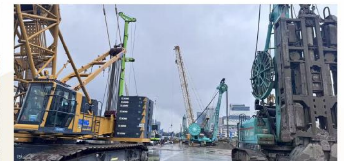
● 杭州市城市轨道交通15号线一期工程土建施工SG15-13标段瓜山站
