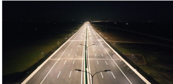
● G235国道义乌(上佛路-金东区界)段工程
