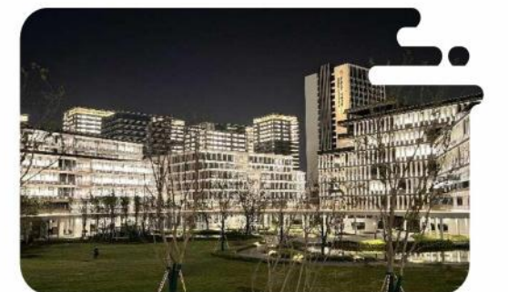
● 萧山西电电子科技产业园泛光照明工程
