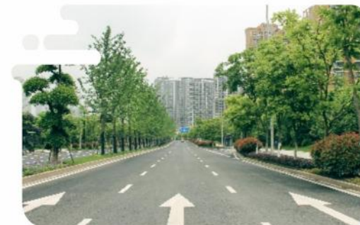
● G20·钱江世纪城建成道路整治及提升改造工程
