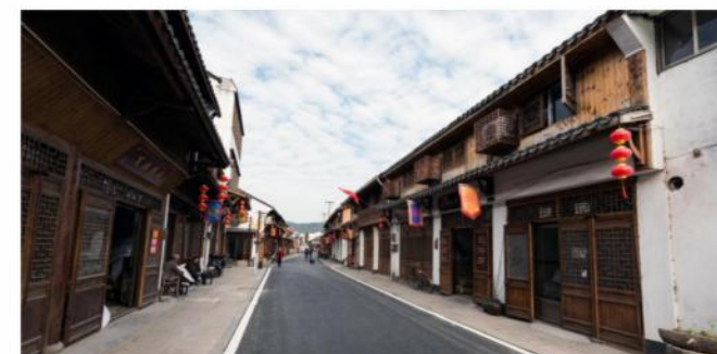
● 义桥老街工程
