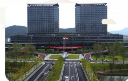
● 台州医院新院区项目（室外配套工程）
