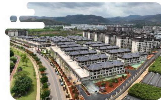
● 云南省开远市里仁和庭建设工程总承包项目
