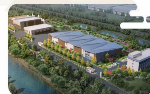
城东分类减量综合体EPC工程总承包项目
