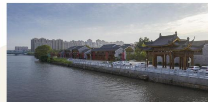
● 杭州湾山海生态绿道工程（一期）总承包（EPC）项目（古建筑）
