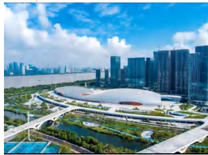
● 杭州奥体 中建八局承建
