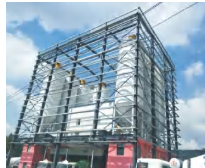
● 海宁中胜建材有限公司混凝土搅拌站封装
