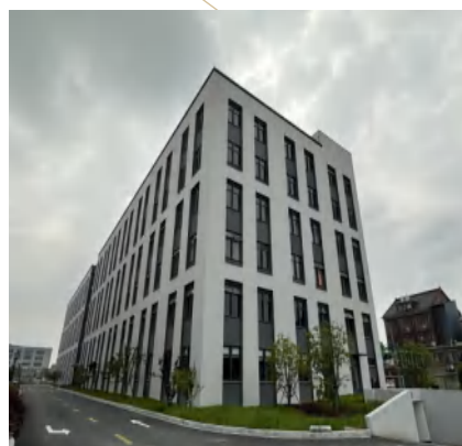
● 杭政工出（2020）26号地块工业项目（新制造业项目）
