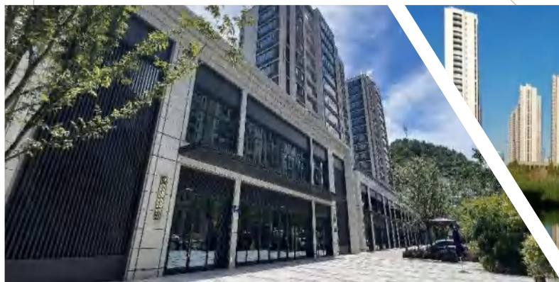
● 杭州临安锦南新城人才租赁用房项目工程
