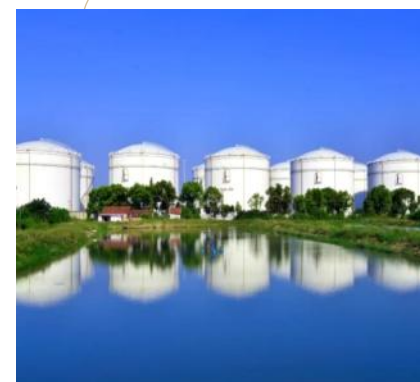
● 中石化绍兴油库油罐防腐工程
