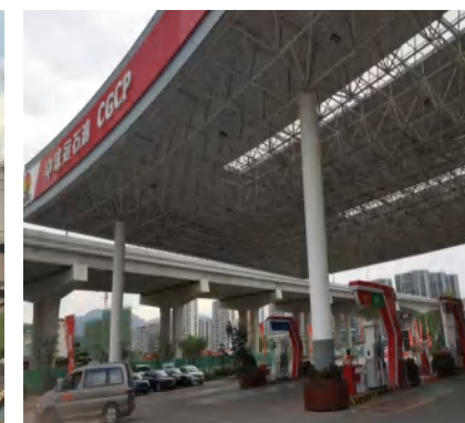
● 中球冠老地方加油站网架防腐工程
