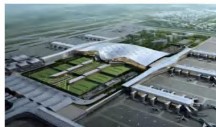
● 杭州国际机场三期项目新建航站楼
