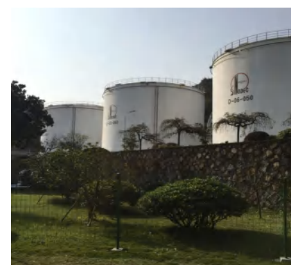
● 中石化苏台山油库油罐管线防腐工程
