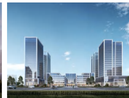
● 杭州汇宇热店场智造产业园项目
