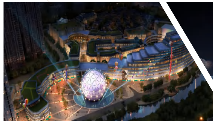
● 梦世界电影文化综合体一期工程
