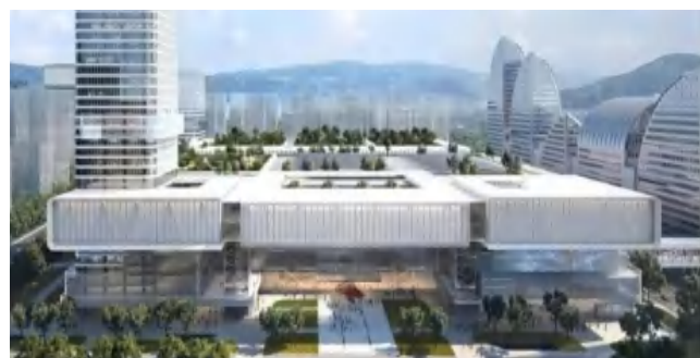
● 国际博览中心二期项目
