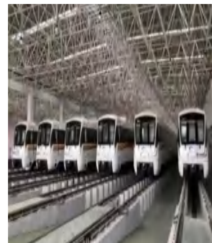
● 杭州地铁 号线工程盈中车辆段项目
