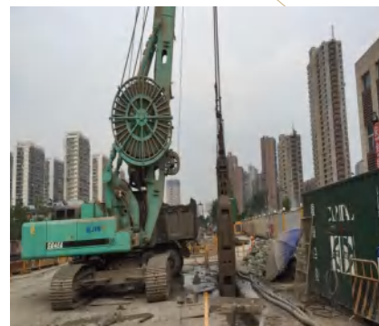
● 地铁6号线杭州振浦路站地下连续墙工程
