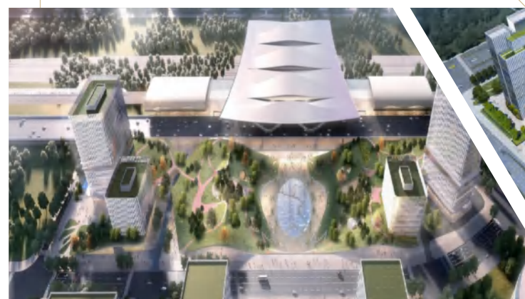
● 杭甬高铁衢州西站综合交通枢纽及配套项目
