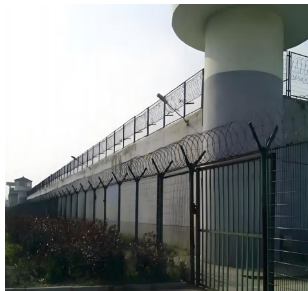
● 杭州杭新实业有限公司临时设施(圍牆崗樓、隔离网等)项目
