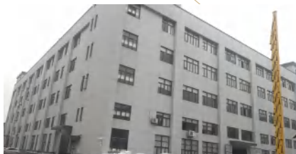
● 杭州丰绩五金机械有限公司-年产400吨通用零部件项目车间工程框架四层结构
