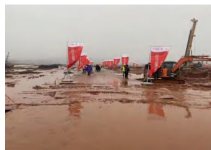
● 浙江义欣新能源动力电池生产基地项目EPC工程
