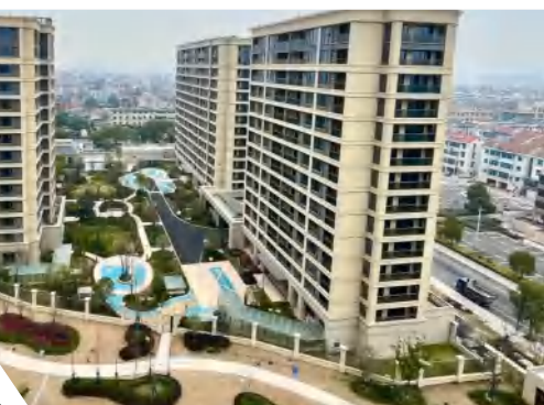
● 空港新城城市示范村（靖江区块）二期项目
