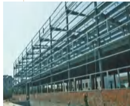
● 杭州满宇卫生用品有限公司三层钢结构厂房
