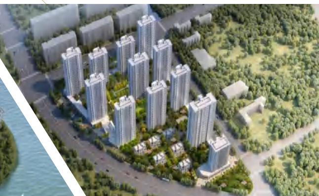
● 萧政储出（2021）35号地块项目
