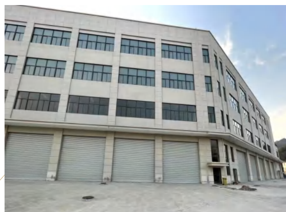
● 浙江大凌机电设备有限公司新建车间
