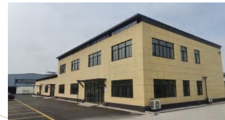
● 靖江街道协谊村美丽乡村示范村创建项目-邻里中心新建项目
