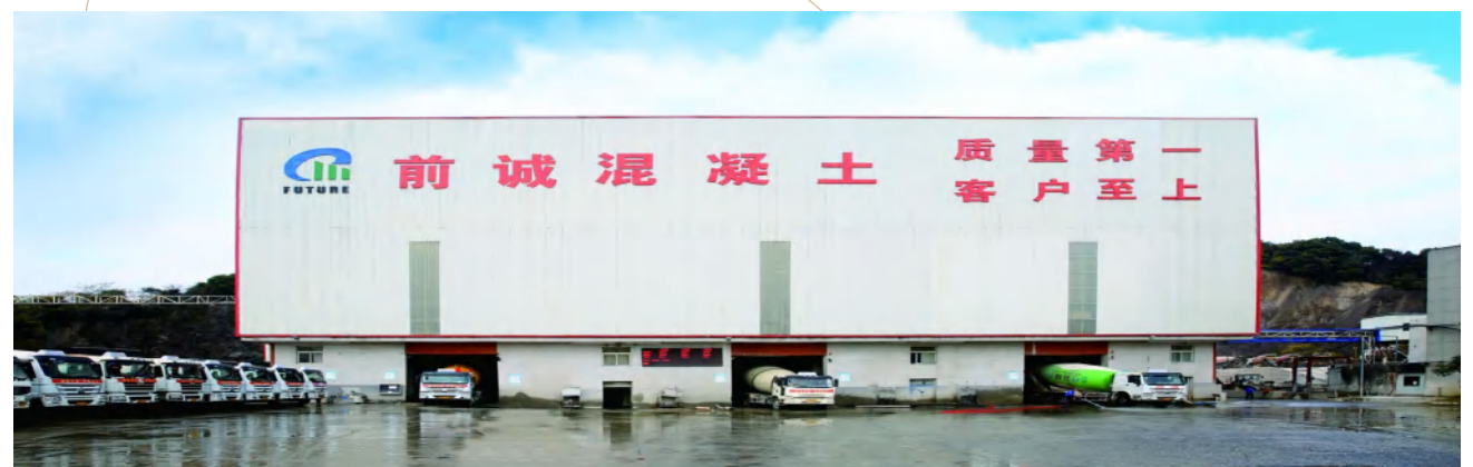
● 杭州前诚混凝土有限公司搅拌楼图
