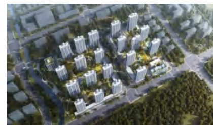
● 党湾未来交通新镇一期安置房项目EPC工程总承包(东区块)
