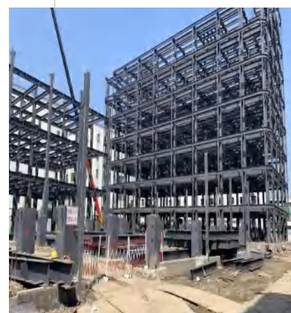
● 上海联博安防器材股份有限公司改扩建厂房项目
