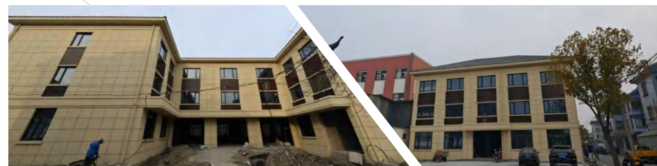
● 东桥村便民服务站
