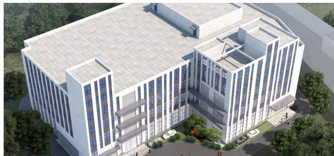
● 杭州恬悦布艺有限公司年产1500万米特种布艺面料生产线项目
