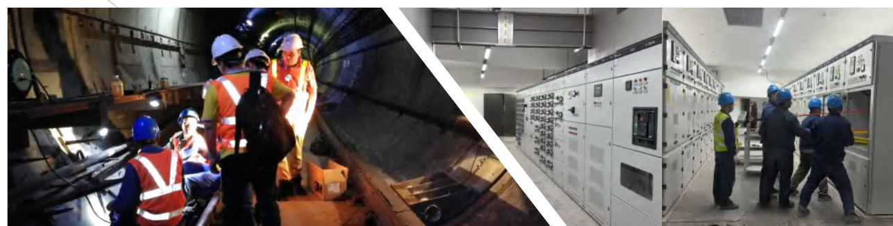
● 地铁一号线抢修
