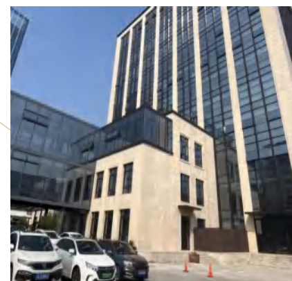
● 杭州巨星科技股份有限公司九堡总部改造
