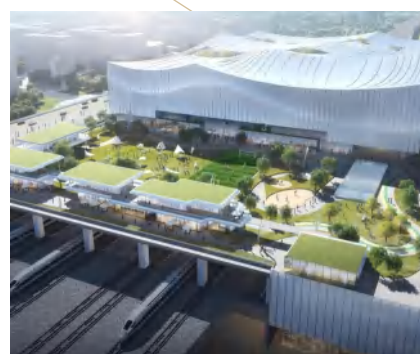
● 铁路杭州萧山机场站枢纽及接线工程钱塘站站房及相关工程
