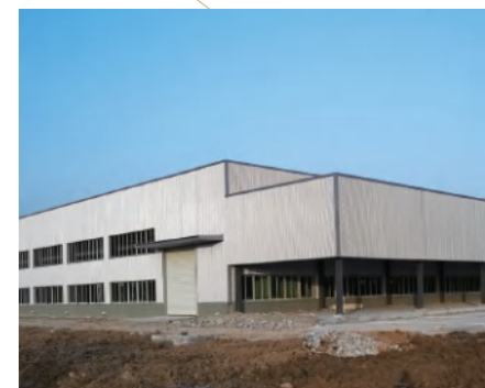
● 湖州哈特贝尔厂房 (浙江省建筑钢结构金奖)
