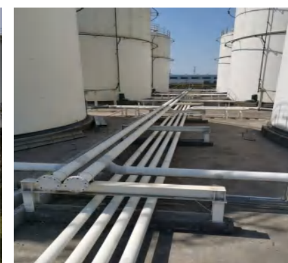
● 中石化康桥油库油罐管线防腐
