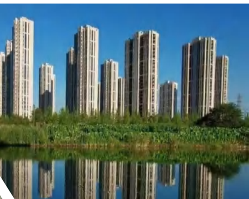
● 蜀山街道金西村湘湖三期安置用房工程2标段工程
