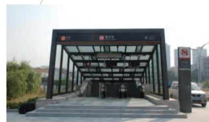
● 地铁2号线潘水站
