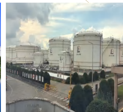
● 中石化萧山油库油罐管线防腐工程
