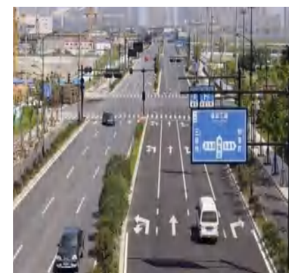
● 钱江世纪城博奥路（机场公路~建设四路）工程
