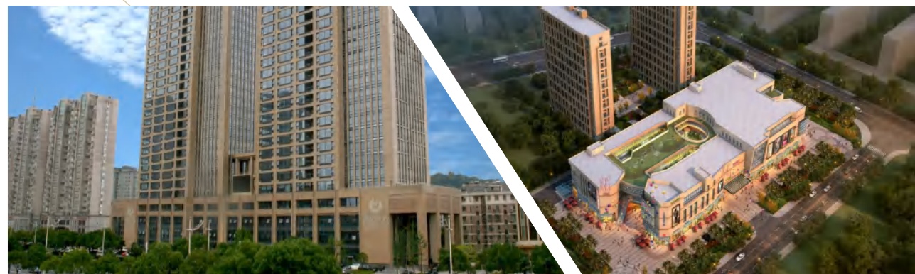
● 萧山区供水调度大楼扩建工程
