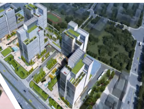
● 杭政储出(2018)25号地块商业、商务用房项目
