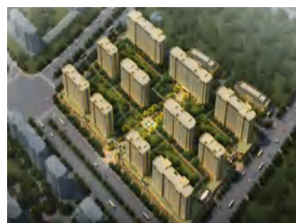
● 空港新城城市示范村(南阳区块)二期项目一标段
