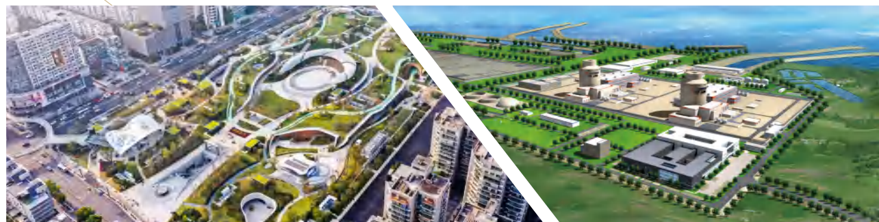
● 杭州临安人民广场
