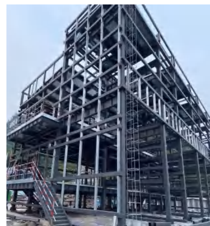
● 杭州草漾110千伏输变电工程
