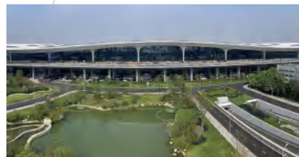
● 杭州萧山国际机场三期工程
