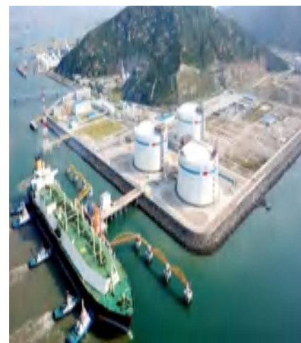
● 中海油广东珠海LNG项目一期工程
