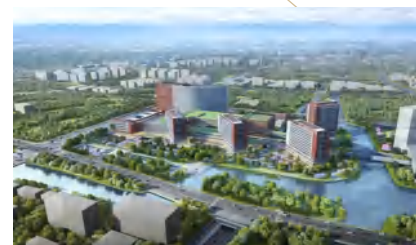
● 浙大二院萧山院区(一期)工程
