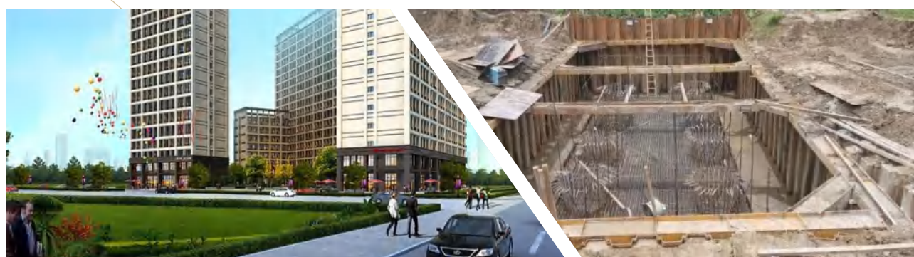
● 利丰广场C座公寓及公区精装修工程
