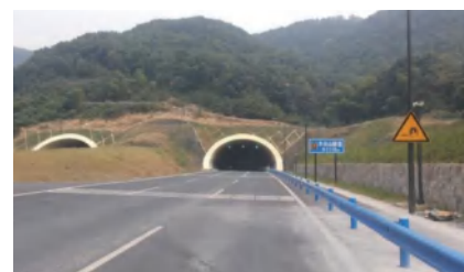
● 绕城高速03省道隧道
