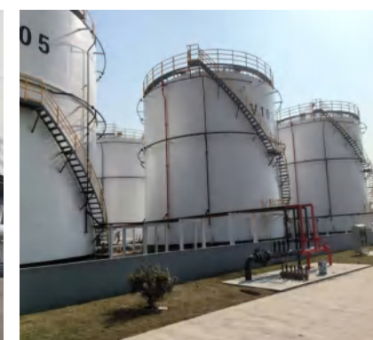
● 中球冠长兴中山油库油罐管线防腐工程
