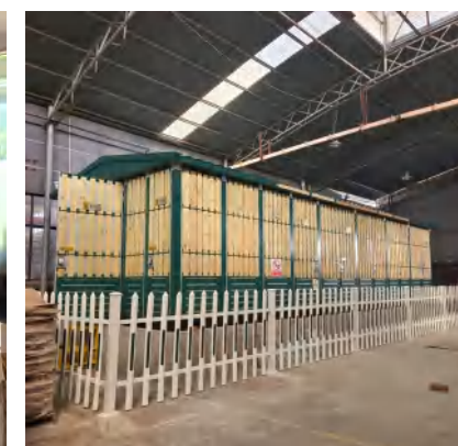
● 杭州佳宝卓邨商业管理有限公司2台1250KVA配电设备安装工程
