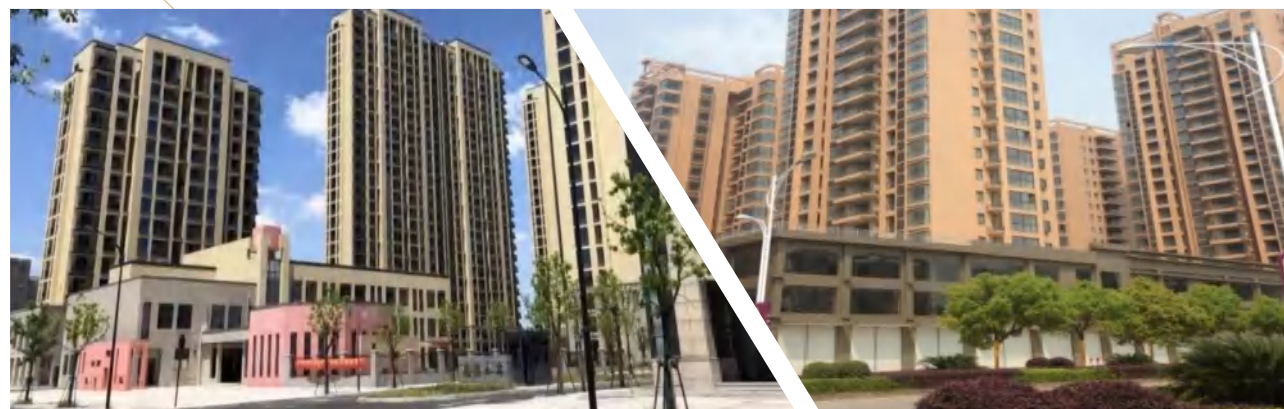
● 萧山蜀山市政地块拆迁安置房
