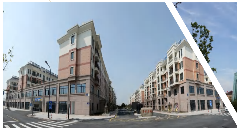
● 新湾街道城市综合体建设安置房1-20号楼、地下车库（华彩名府小区）
