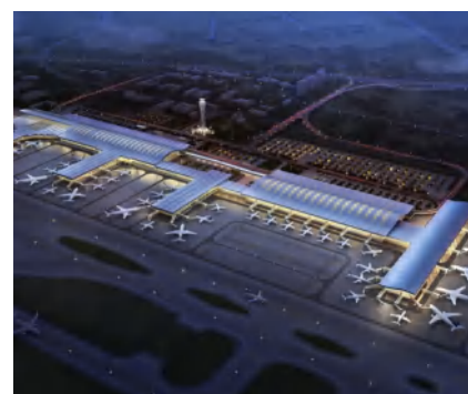
● 贵阳龙洞堡国际机场T3航站楼
