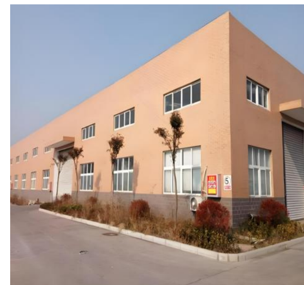
● 衙前镇杨汛村旧厂房改造工程工程
