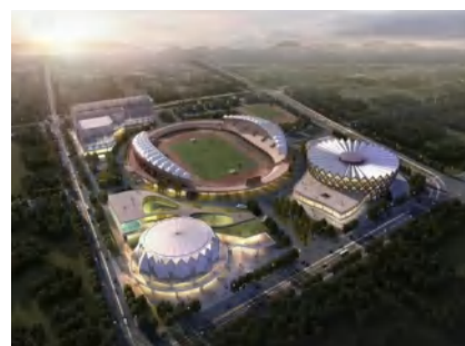
● 丽水市体育中心游泳馆、体育生活馆主体工程
