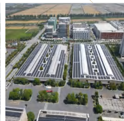
● 杭州圣奥控股有限公司一期2973.5kWp、二期1780.68kWp分布式光伏发电项目工程
