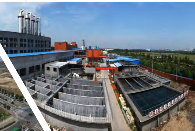
● 杭州福莱茵特精细化工有限公司后处理车间、污水处理池项目
