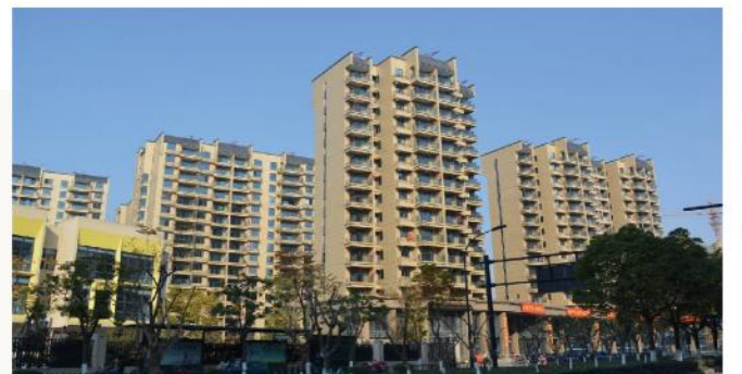
● 黎明社区农转非居民拆迁安置房外墙涂料工程
