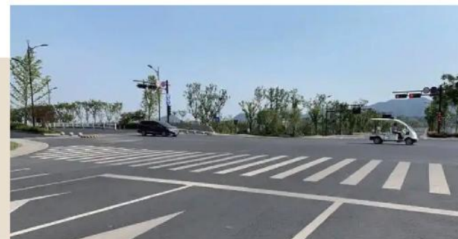
● 湘湖路(杨堤--眉山路)道路拓宽工程
