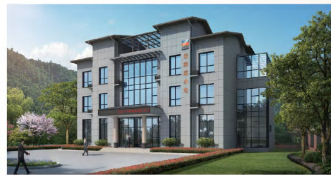
● 龙泉岩樟溪水电公司
