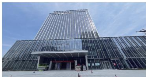
● 英特药谷运营中心建筑装饰装修项目
