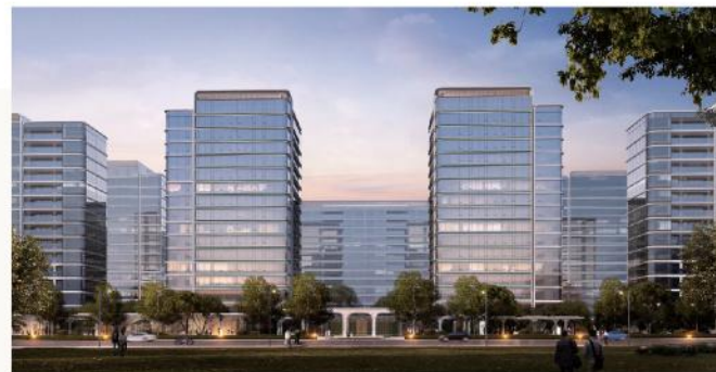
● 杭政储出【2023】66号地块商品住宅（设配套公建）项目（一标）幕墙及铝合金门窗工程
