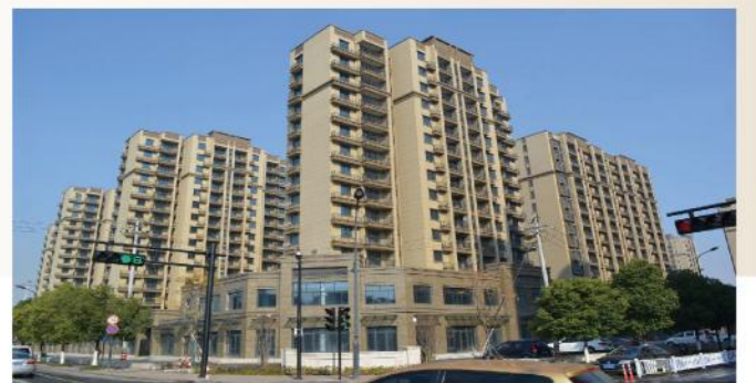
● 临东家园二期一标段3#7#4#外墙涂料工程
