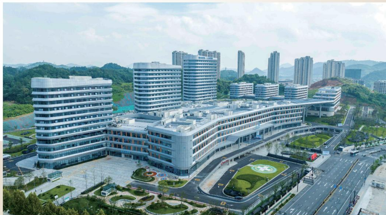
● 临安区人民医院及妇幼保健院拆迁项目(一期)室外道路、管线、景观绿化及附属工程
