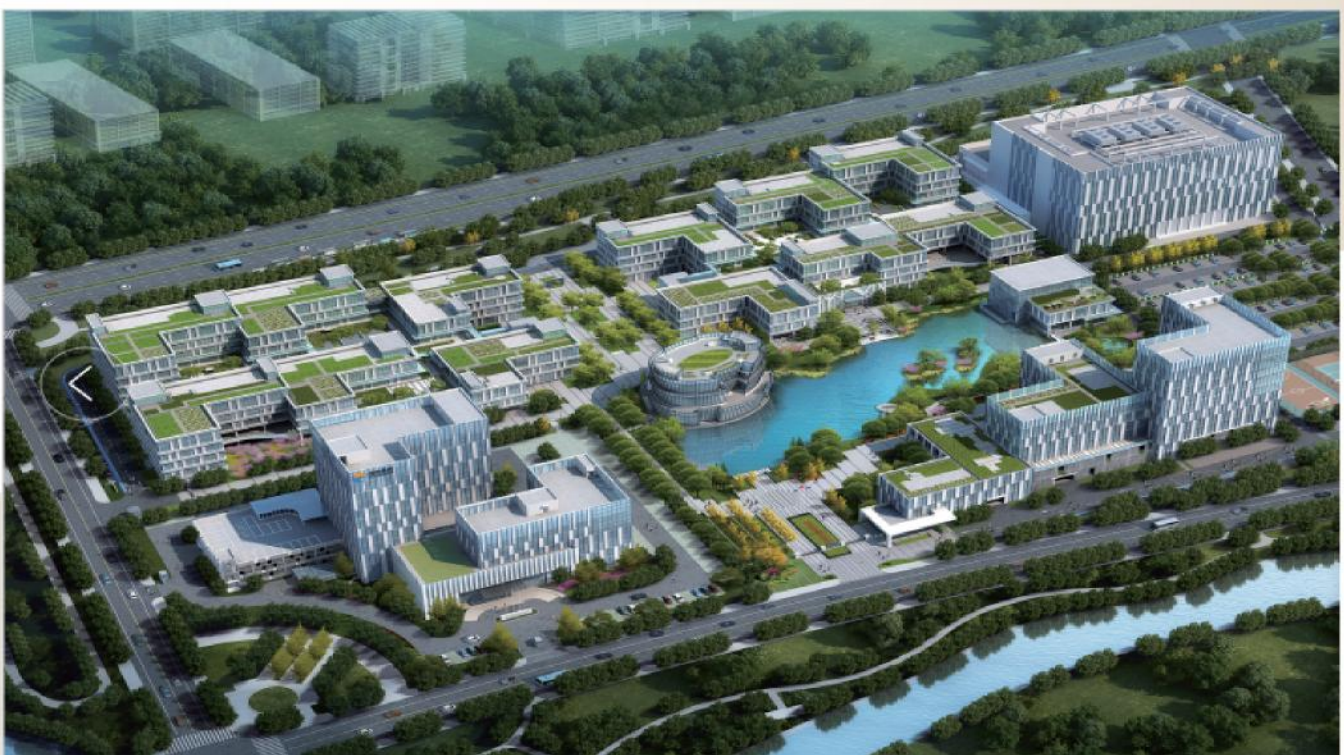
● 中国电信浙江创新园幕墙工程
