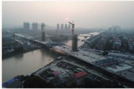
● 湖州长湖申大桥整体涂装工程
