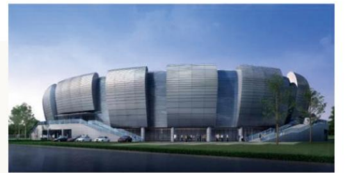
● 杭州市滨江体育馆项目
