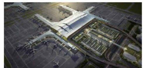
● 西安咸阳国际机场三期扩建工程东航站楼
