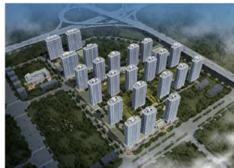
● 宁牧安置房精装修工程
