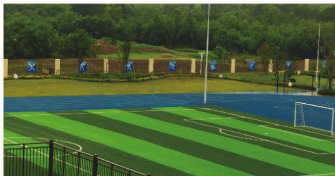
● 阜阳观澜学府项目小学交付区景观及雨污管网工程
