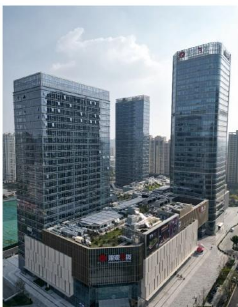
● 杭政储出(2017)24号地块商业商务设施用房项目
