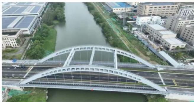
● 高新区城北高新园环城北路东延(青春路—伟业路)工程
