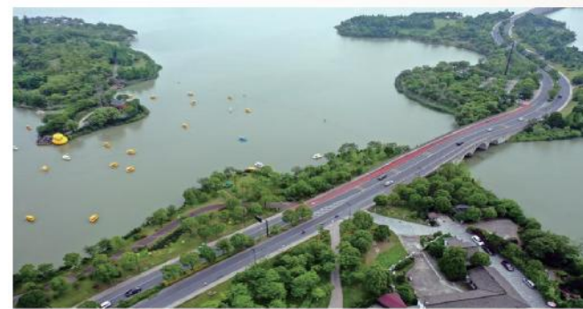
● 湘湖路(杨堤--眉山路)道路拓宽工程
