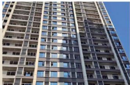
● 台州经中路门窗幕墙工程
