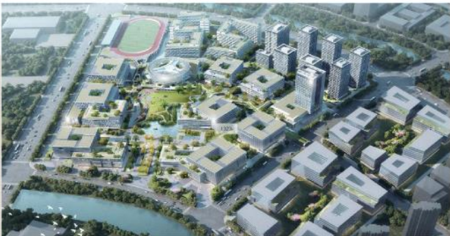
萧山西电电子科技产业园
