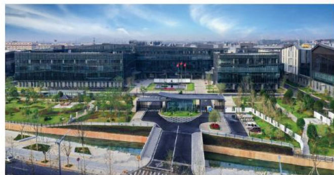
● 旺达浙江锂电产业园圆柱锂电池项目-消防工程
