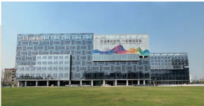
● 浙江长龙航空创新智能维修保障主基地研发楼
