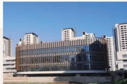
● 湘湖公学项目铝板幕墙和门窗工程
