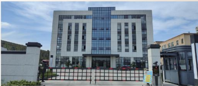
● 千家伴新材料科技有限公司装修工程
