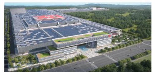
● 萧山西电电子科技产业园
