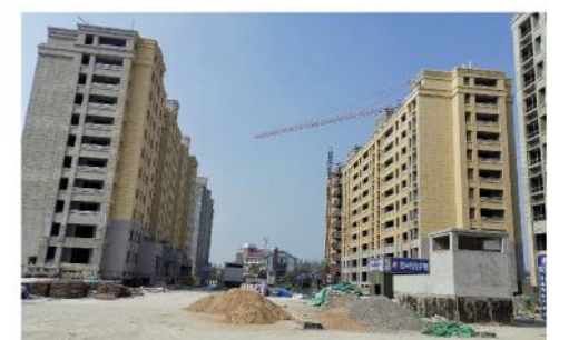
● 金都檀宫二期一标段27# ~ 33#楼外墙涂料工程
