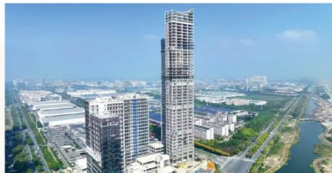
● 诺德智联中心项目幕墙工程
