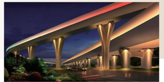
● 东湖立交桥景观照明工程
