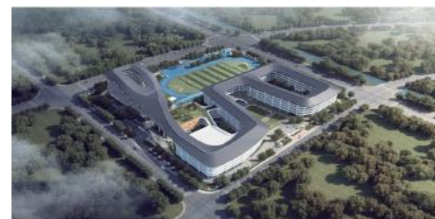
● 杭州硅谷中学项目室内精装修工程
