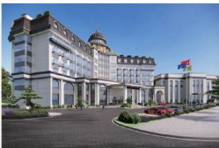
● 衢州大花园国际酒店装修改造项目
