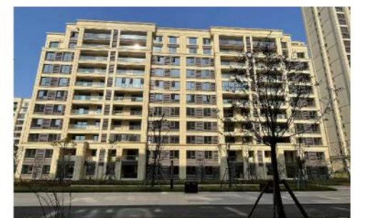
● 九江市跨贸小镇一期1.2标外墙涂料及室外景观
