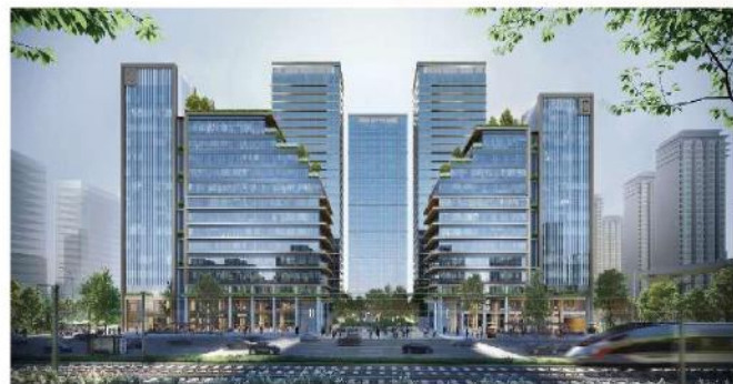
● 萧政储出（2021）25号地块项目EPC工程幕墙工程
