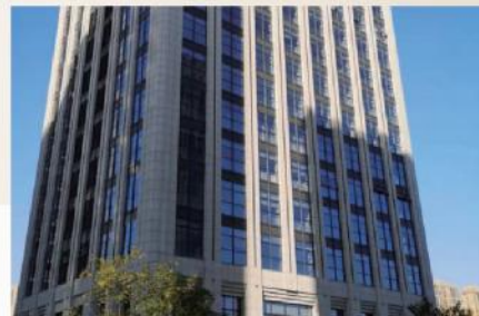
● 临安旭悦城幕墙工程
