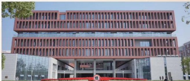
杭州电子科技大学第一实验楼装修工程
