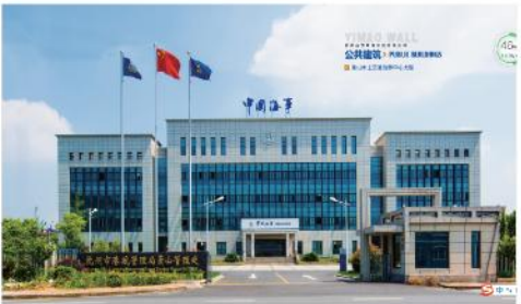
● 萧山水上交通指挥中心大楼
