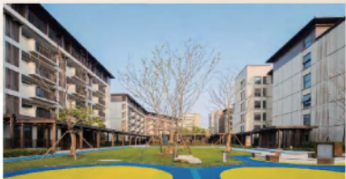
● 杭政储出【2017】6号地块商业商务综合用房精装修工程
