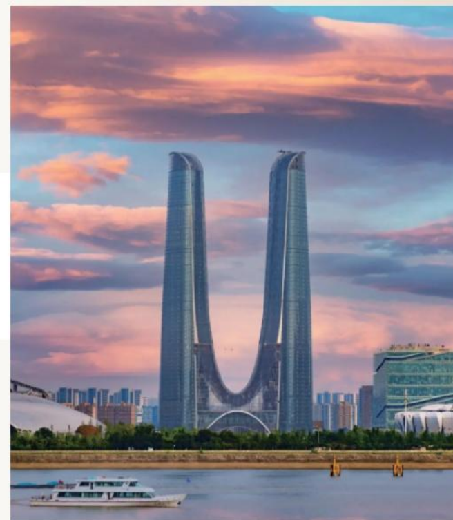
● 地中心·杭州之门（一期）装修工程
