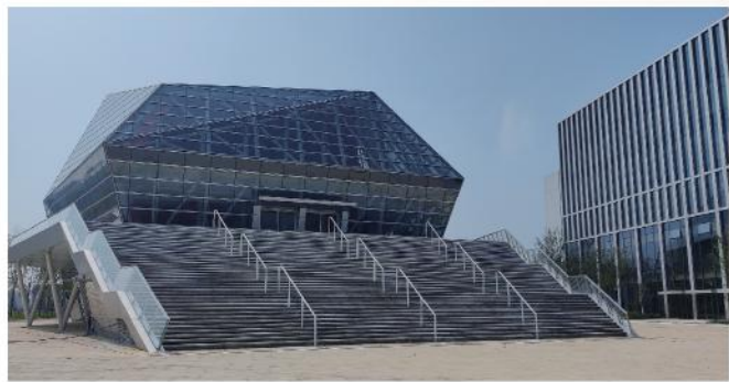
● 浙江大学杭州国际科创中心项目①
