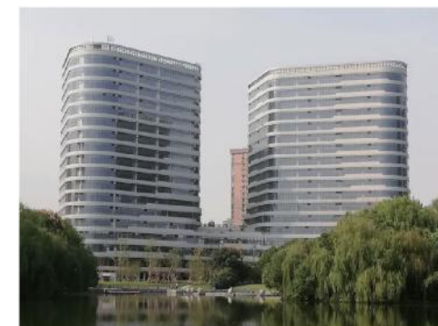
● 杭政储出【2018】30号地块商业兼容商务用房
