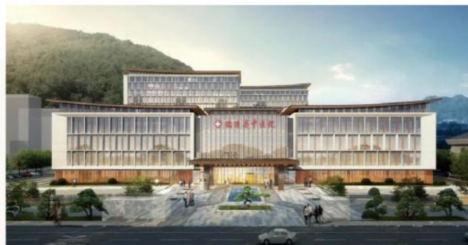
● 德清中医院整体迁建-消防工程
