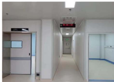
● 结核病诊疗中心搬迁装修改造
