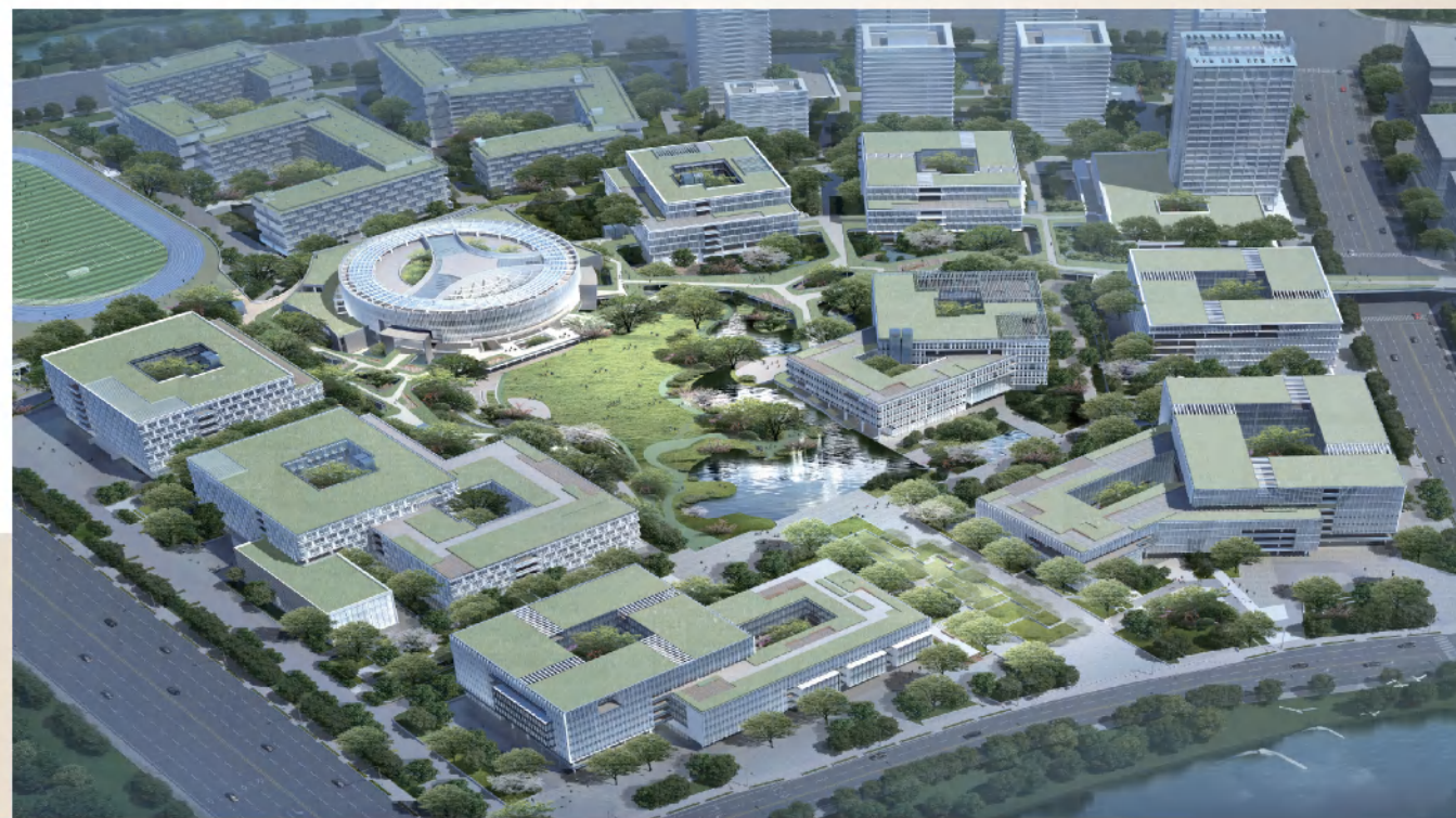
● 萧山西电电子科技产业园EPC精装修工程
