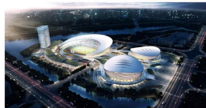
● 温州瓯海奥体龙舟运动中心项目
