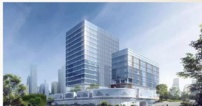
● 佳和电气综合能源中心生产及研发项目幕墙工程
