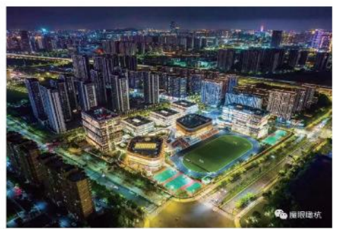
● 钱江世纪城初中新建项目精装修工程
