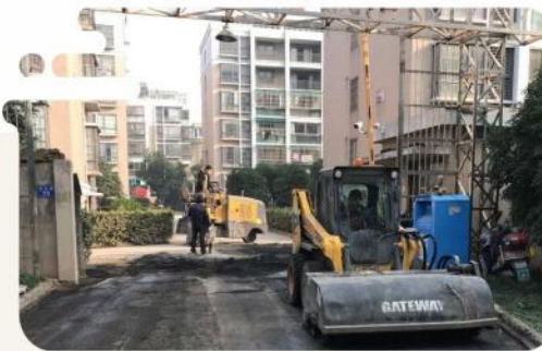
● 党湾“污水零直排”排查与整改工程
