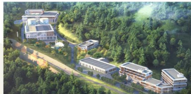
● 余杭区镜子山资源循环利用中心项目设计采购施工（EPC）工程总承包项目
