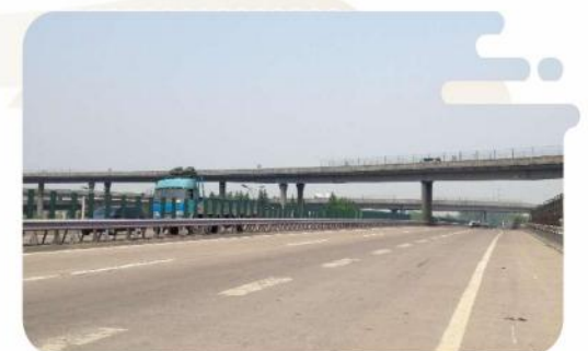
● 杭州乔司全南苑连接线下穿沪杭客专工程地面道路项目施工
