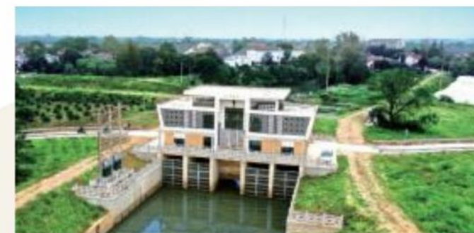
● 长兴泗安塘流域综合治理项目
