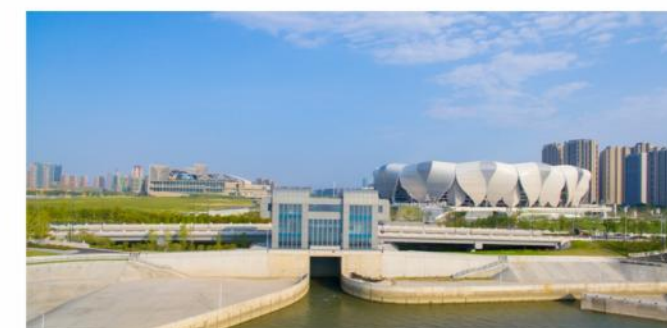
● 萧山区钱塘江（七甲闸至五堡闸段）海塘加固及船闸工程
