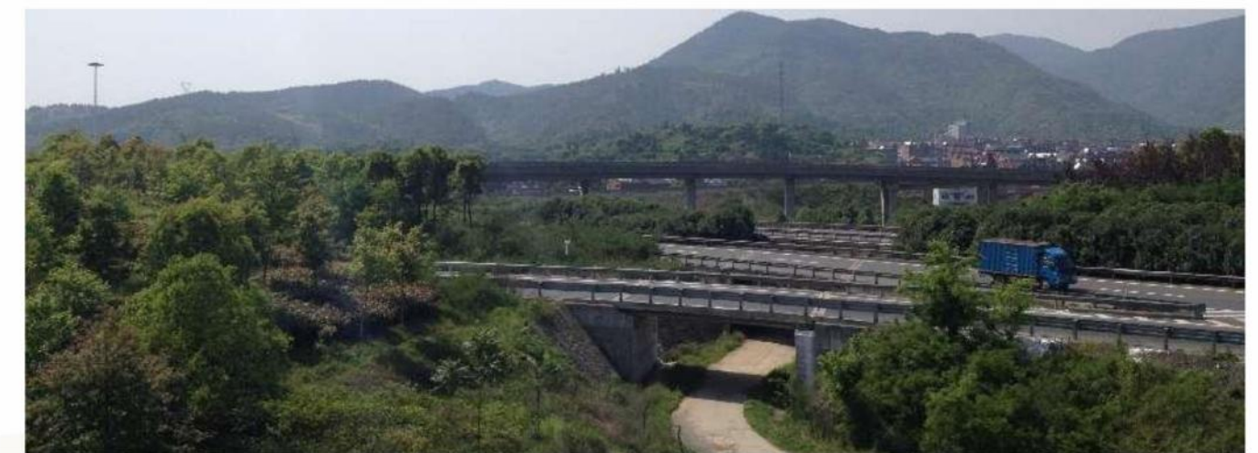
● 杭州乔司至南苑连接线下穿沪杭客专一号通道工程施工
