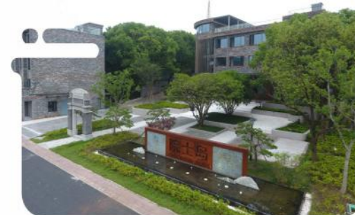
● 湘湖院士岛市政景观改造工程-入口景观工程
