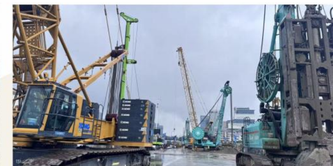
● 杭州市城市轨道交通15号线一期工程土建施工SG15-13标段瓜山站
