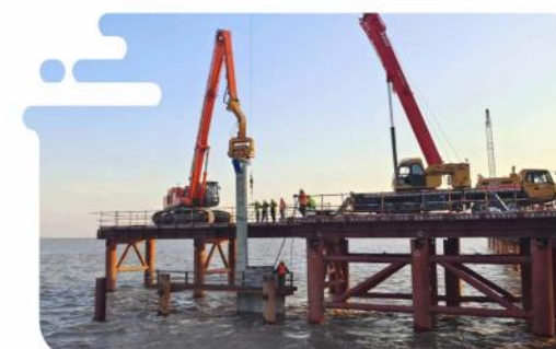
● 钱塘江北岸秧田庙至塔山坝海塘工程（堤脚部分）
