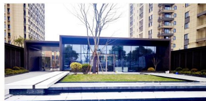
● 杭政储出(2018) 1号地块人才专项租赁住房提升改造项目
