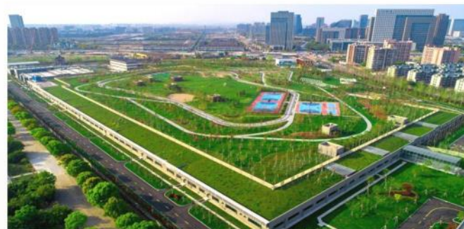
● 杭州市七格污水处理厂四期工程（一期）
