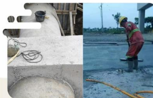
● 杭州至宁波国家高速公路（杭绍甬高速）杭州至绍兴段工程第四分部圆管涵施工
