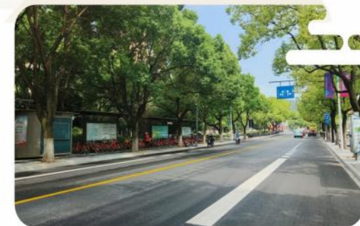
● 2023年亚运通勤道路提升工程人行道整治
