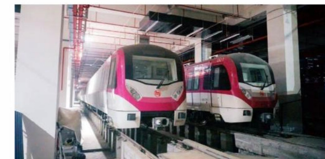
● 杭州地铁8号线新湾车辆段站场路面工程
