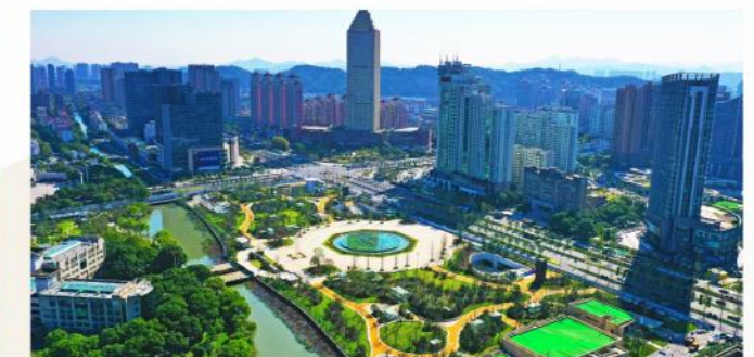
● 萧山区人民广场地下空间开发项目地面景观工程
