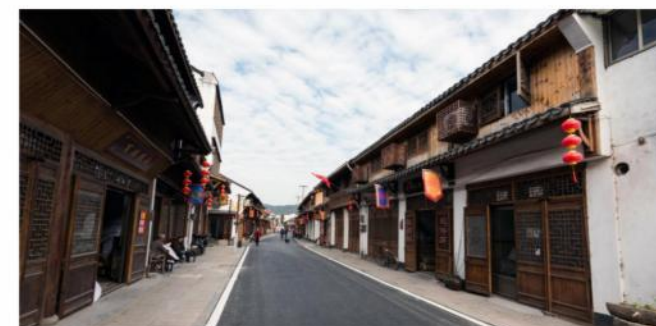
● 义桥老街工程
