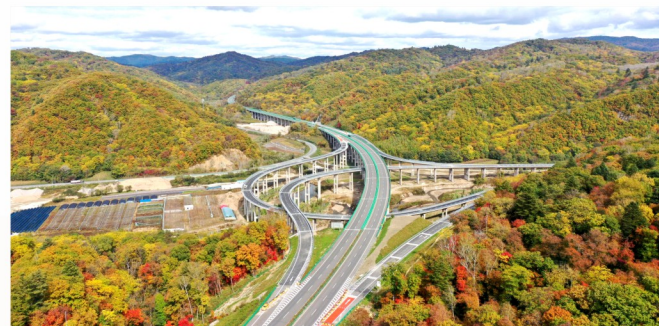
● 珲春至乌兰浩特高速公路吉林至黑河联络线吉林至荒岗(省界)段工程
