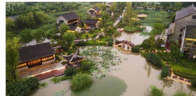
● 沙庄古村临湖及村口片区文旅节点工程EPC总承包
