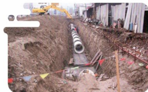
● 03省道东复线北伸污水管工程
