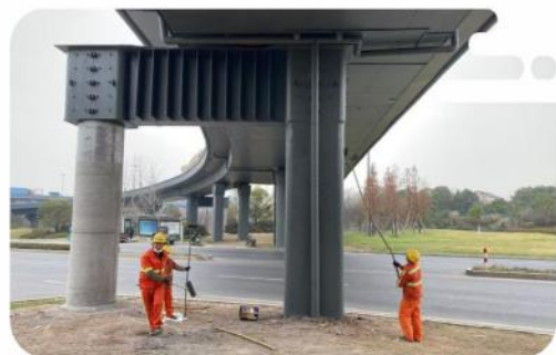
● G235新海线金东段十八里互通和仙桥互通桥梁独柱墩加固应急抢修工程第1标段
