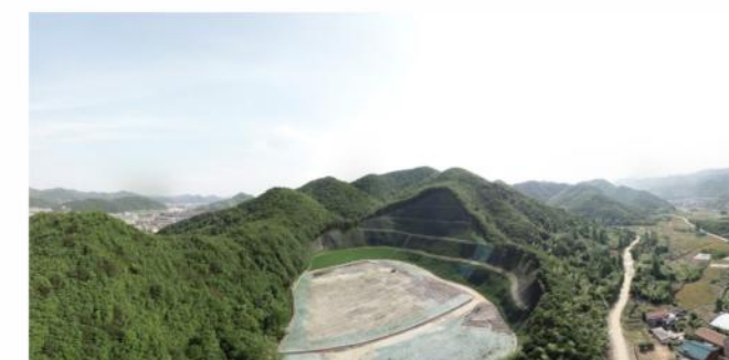
● 杭州萧山河上镇高都轧石废弃矿山生态环境治理工程
