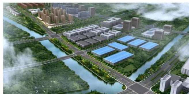
● 池杉路（滨江一路-滨江二路）道路及管廊工程
