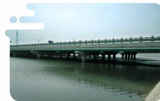
● 温州高教园区北入口桥梁工程
