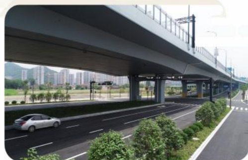
● 杭州市萧山区通城大道快速路并行铁路路段工程
