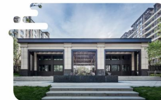
中国金茂青岛高新区项目A5地块园林景观工程
