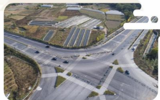
浦江水晶生态集聚区快速通道建设工程
