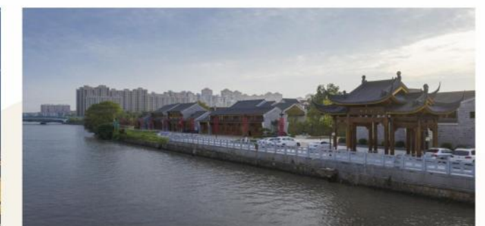
● 杭州湾山海生态绿道工程（一期）总承包（EPC）项目（古建筑）
