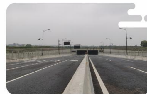
● 保税大道南伸工程(隧道段)-雷山湾河钢筋砼框架桥施工分包项目
