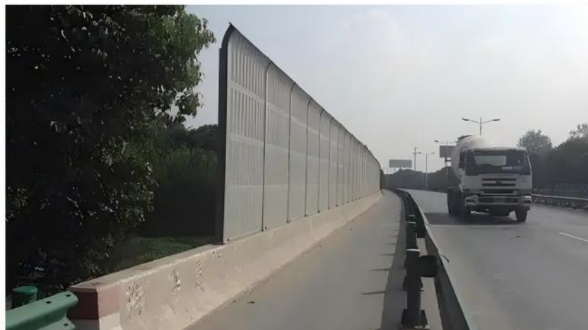
● 104国道声屏障安装工程
