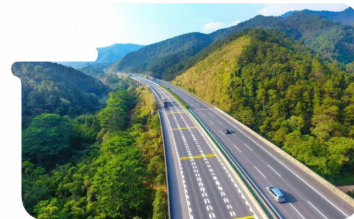
● 广州至河源高速公路惠州段工程
