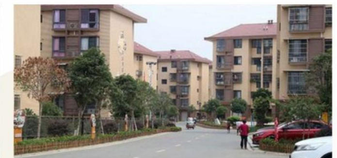
● 星联村安置小区配套工程
