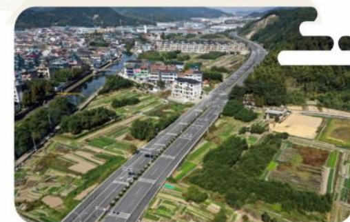
● 柯桥西南通道工程
