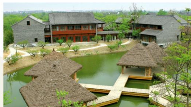
● 杭州市西溪湿地综合保护工程一期工程历史建筑复建和修缮工程
