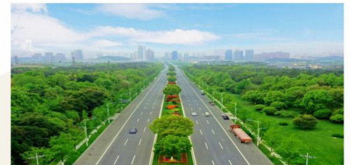
● 迎春南路(320国道-杭千高速入口)景观工程
