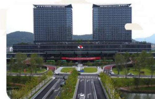
● 台州医院新院区项目（室外配套工程）
