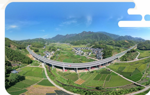
● 528国道遂昌新路湾至石练段改建工程第SJSJG02标段
