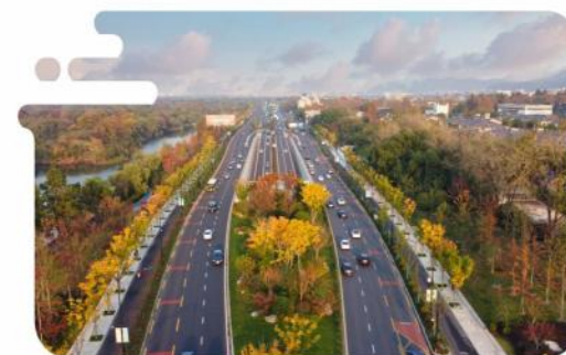
● 天目山路提升改造工程
