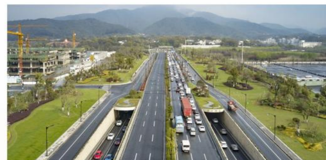
● 紫之隧道路面工程
