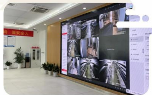
● 钱江世纪城综合管廊项目
