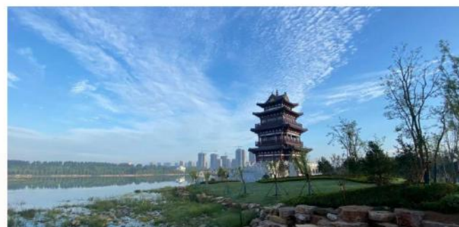
● 邹城市杨下河景观建设 PPP 项目
